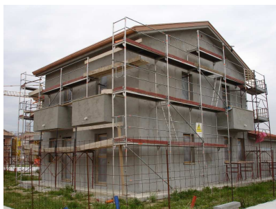
Rasatura completata. Superficie pronta per la tinteggiatura
