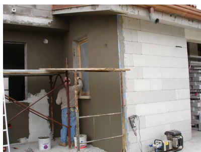
Prima rasatura della finitura "a cappotto"
