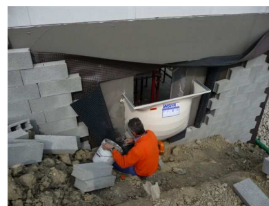
Rivestimento con guaina su parete rasata e successiva protezione
