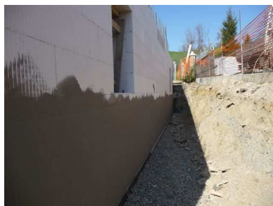
Preparazione della superficie con doppia rasatura e retina annegata
