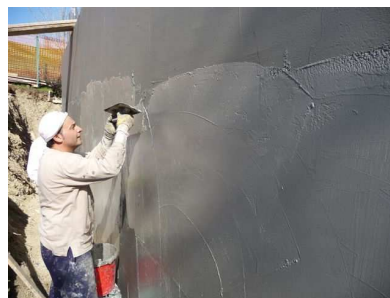
Impermeabilizzazione con soluzioni liquide stesa a spatola
