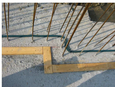
Posizionamento giunto bentonitico
