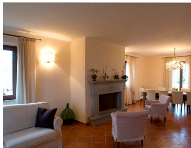
Finiture a cornice incollate su camino
