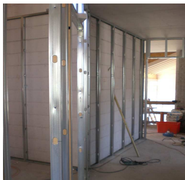
Posa delle lastre con struttura metallica
