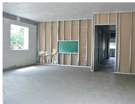
Pareti divisorie interne con struttura metallica
