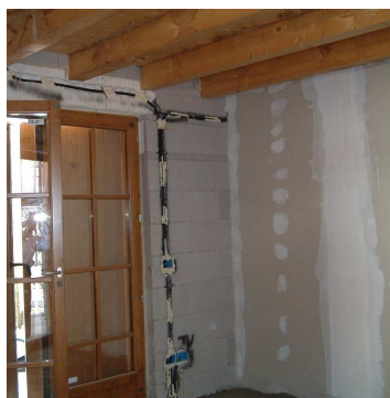
Posa delle lastre in aderenza e stuccatura dei fori
